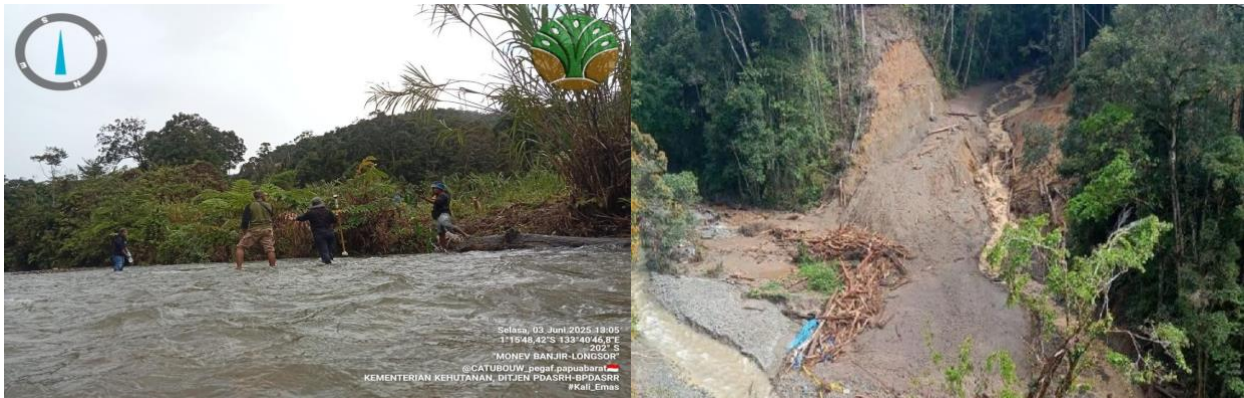
Gambar 2. Kondisi pascakejadian banjir bandang dan tanah longsor di Kampung Jim
